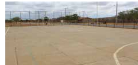
Figura 06: Quadra Poliesportiva da Escola Antônio Francisco antes da reforma
