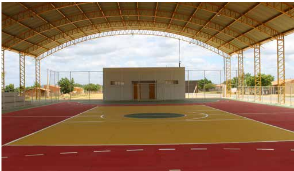
Figura 05: Imagem da conclusão de todo o projeto: cobertura, pintura, alambrado e vestiários e banheiros
