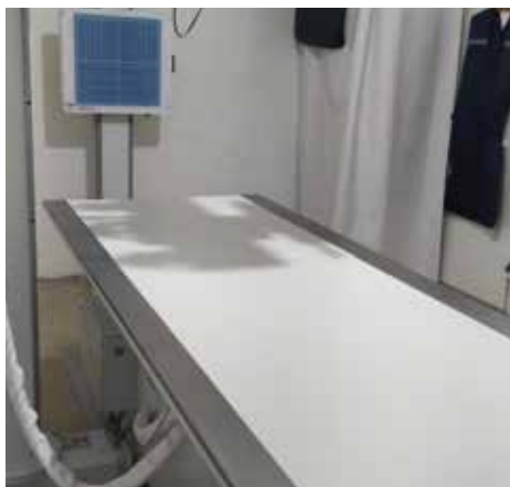
Figura 04: Equipamento de Raio-X instalado
